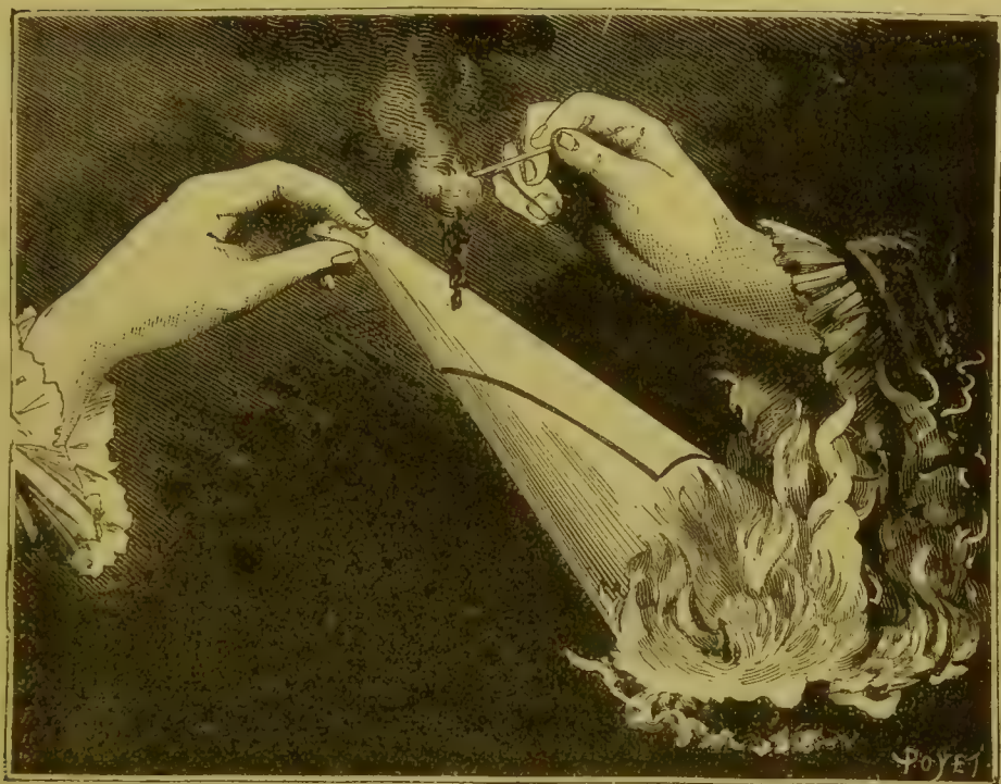
Fig. 215. Produzione del gas illuminante con un cartoccio di carta.
